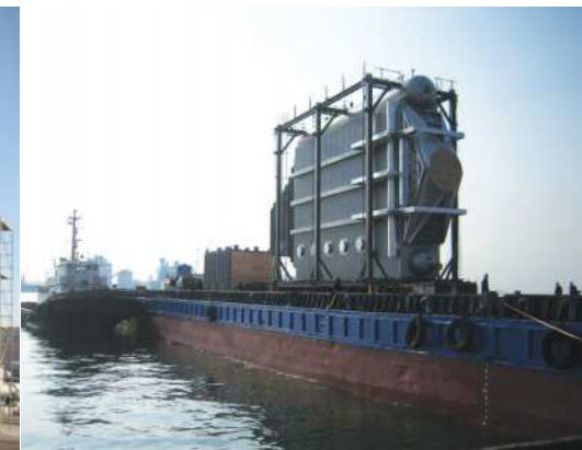
GS칼텍스 VGOFCC 프로젝트 폐열회수 보일러 조립, 운송, 설치 과정
